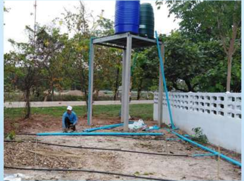
ติดตั้งหอถังสูง
