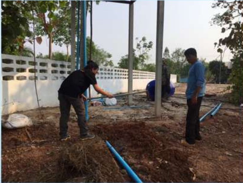
เชื่อมต่อท่อเข้ากับหอถังสูง
